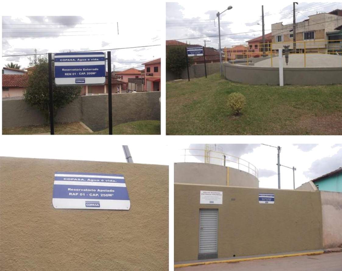
Figura 16: Fotos dos reservatórios REN01(enterrado) e RAP01 (apoiado).
